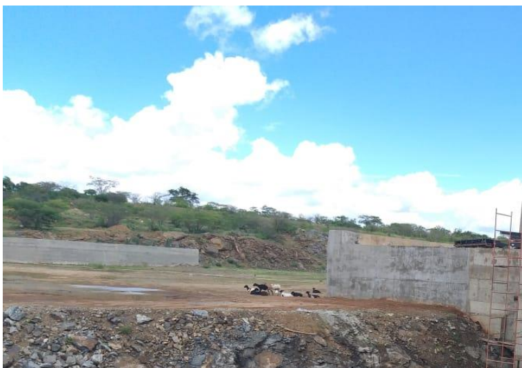
FOTO 3.5 - Vista do extravasor da barragem, escavado em rocha com muros laterais e cordão de fixação em concreto.
