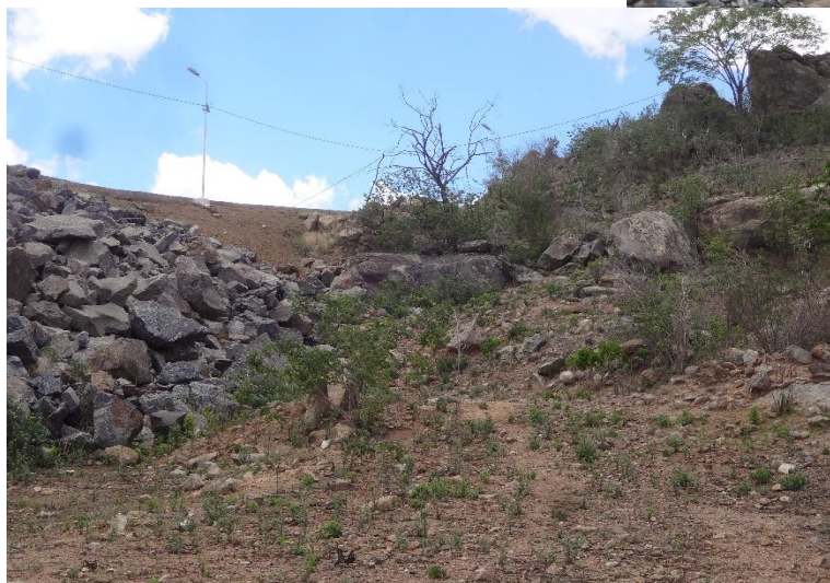
FOTO 3.6 - Detalhe do contato do maciço da barragem principal com a ombreira esquerda.
